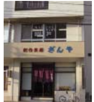
このビルの上2階
